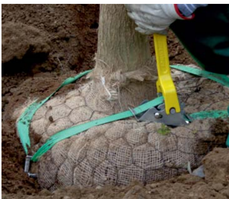
Baumverankerungssystem: Deadman Plati-Mat® & Spezial-Gurtband
